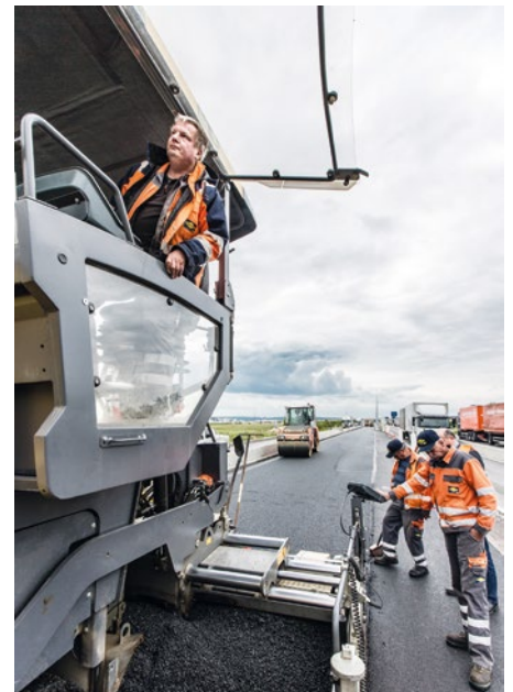
MARTIN SCHÜTZ „dirigiert“ die Asphaltmaschine per Display und Handzeichen.
