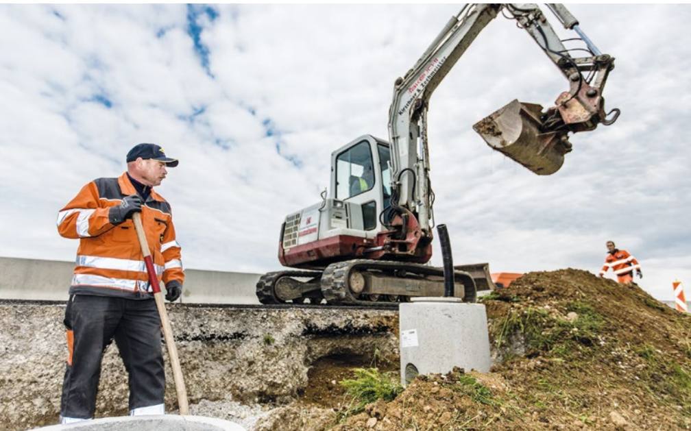
CHRISTIAN MEIDLINGER gehört zu jenem Team, das die zwei Kilometer Kabelschächte für die Beleuchtung im Bereich der Auf- und Abfahrten verlegt.
